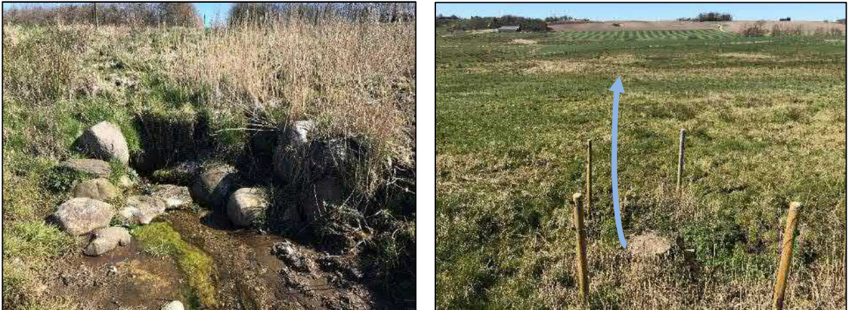
Figur 4. Kilde 2 og drænbrønd der skal fjernes. Vandet vil herefter løbe i retning af blå pil.
